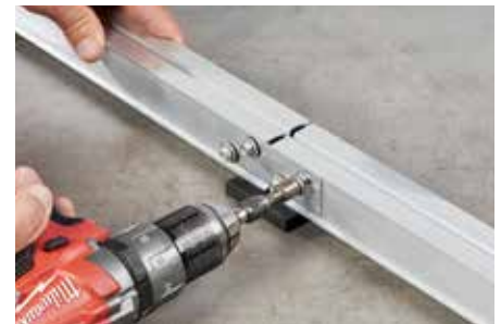
Längsstoß der Unterkonstruktion mit Profilverbinder
